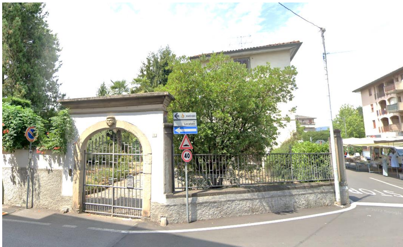
Figura 71a – Edificio vincolato all'incrocio tra via Aldo Moro e via Locatelli (edificio vincolato)
