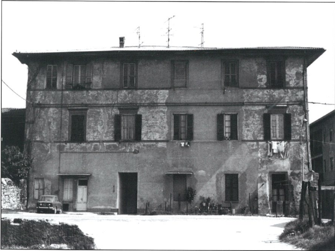
“Ol Palassù”, già proprietà di Barbara Fè Ostiani poi contessa Simoni. Nella fotografia in alto si nota a sinistra il muro che delimita l’area.
