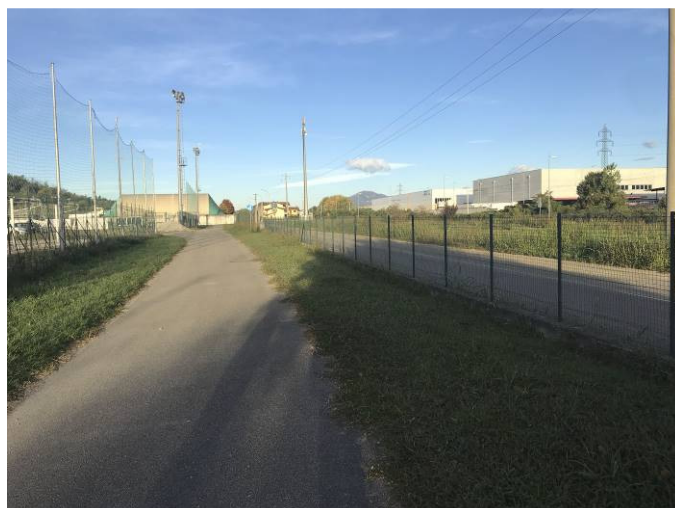
Vista dell'area di ampliamento del campo fino il muretto a nord
