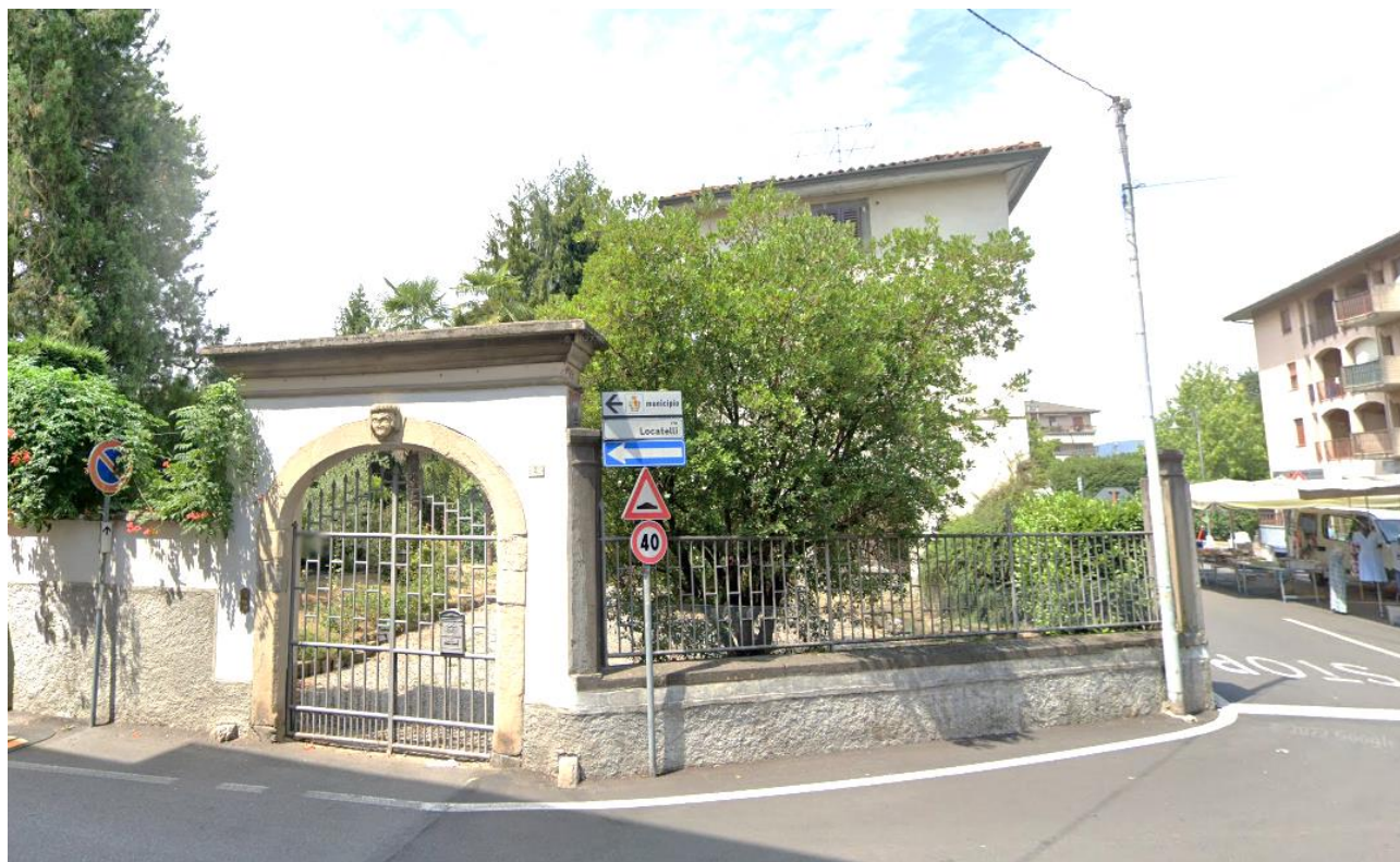
Figura 70 – Edificio vincolato all'incrocio tra via Aldo Moro e via Locatelli (edificio vincolato)
