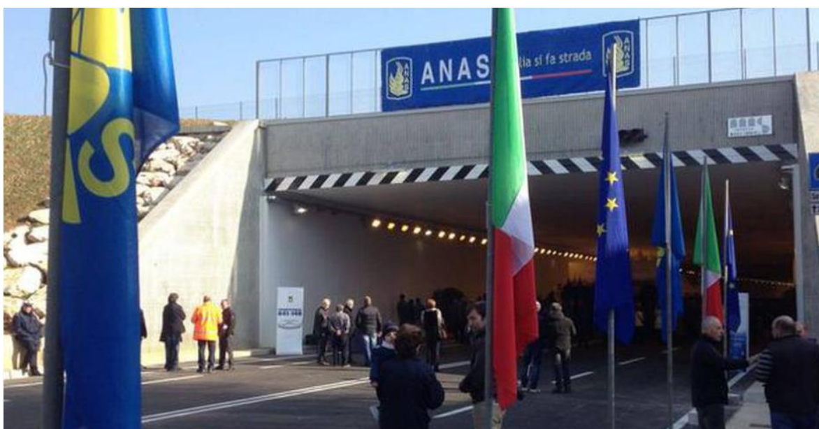
Figura 81 – Inaugurazione variante stradale Albano-Trescore, foto tratta da L'Eco di Bergamo
