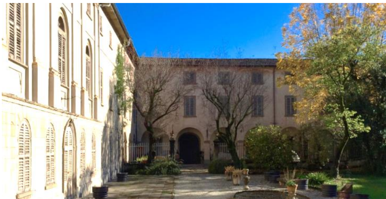
Figura 71 – Villa Salvi Gallizioli (edificio vincolato)
