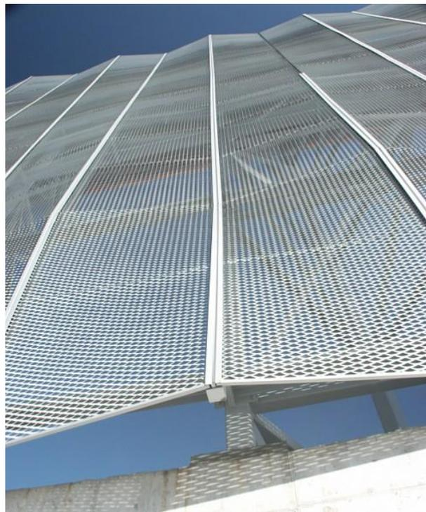
*Figura 3. Lamiera stirata posata a protezione del telaio sismo-resistente in acciaio.*
