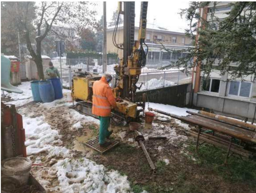
**Fig. 7:** perforazione a carotaggio continuo del sondaggio S1 eseguito in data 30 dicembre 2020
