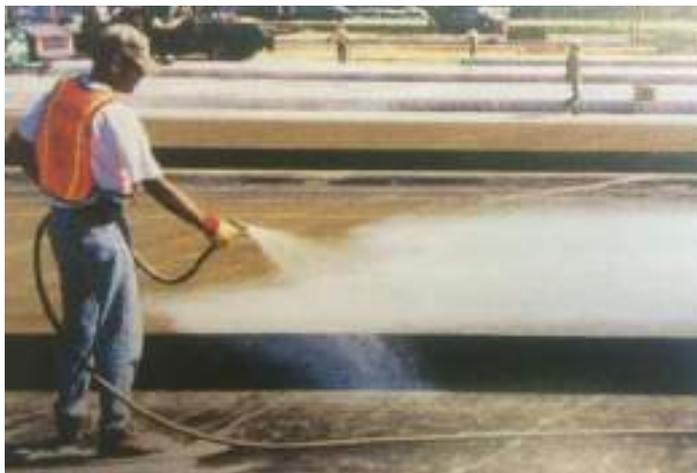
**Figura 3:** Trattamento finale protettivo, consolidante ed Anti Macchia **PRIMIUM FLOOR 600**
