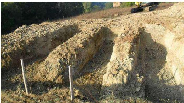
Qualora il suolo naturale fosse costituito di materiale granulare con una buona capacità di carico le camere DRENING possono esservi posate direttamente, senza la stesura della ghiaia. Se, invece, il suolo è particolarmente cedevole lo spessore di ghiaia va aumentato.
